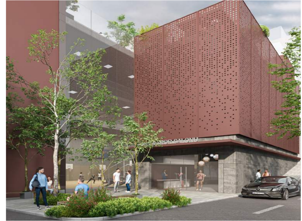
Topağacı Spor Tesisi
